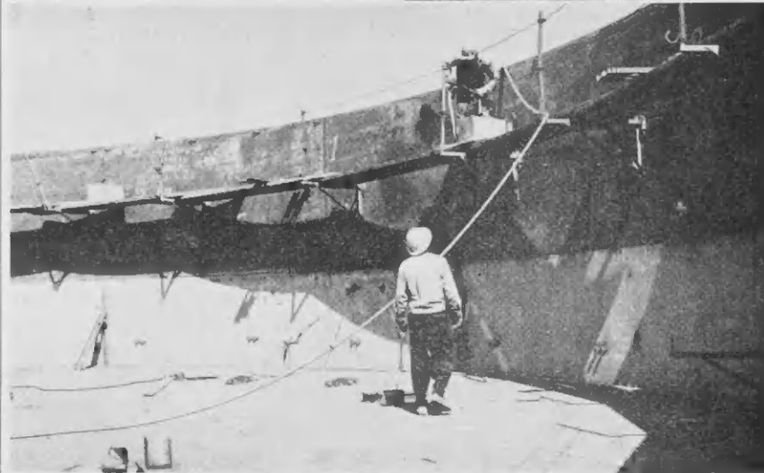
DEN VARIOS fase di construccion den tank farm tin tres tanki grandi di gasoline. Esun di mas grandi tin un capacidad di 80,000 barril. Tur ta tanki cu dak flotante. Pa motibo di aspectonan special incorporá den nan disenjo, e tankinan por usa plachi di staal mas fini y seyo di dak mas eficiente.
